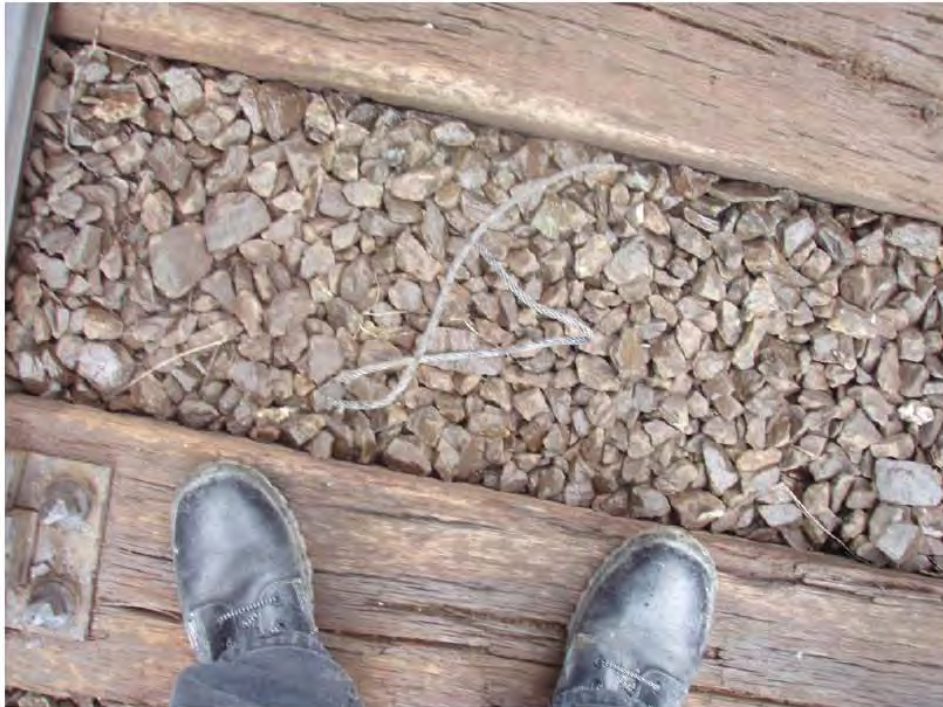
Bild 1: (P6170012 Bf Dallaas Seil.JPG, BMVIT) Bild des Auftraggebers vom Schadensseil am Fundort.
