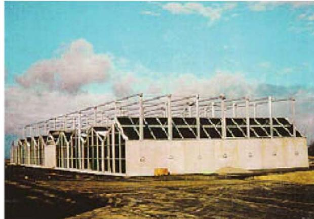
**Abbildung 9-27: Rottemodule mit einer automatisierten Klappabdeckung (Kühner, 2001<sup>[PS235]</sup>)**
