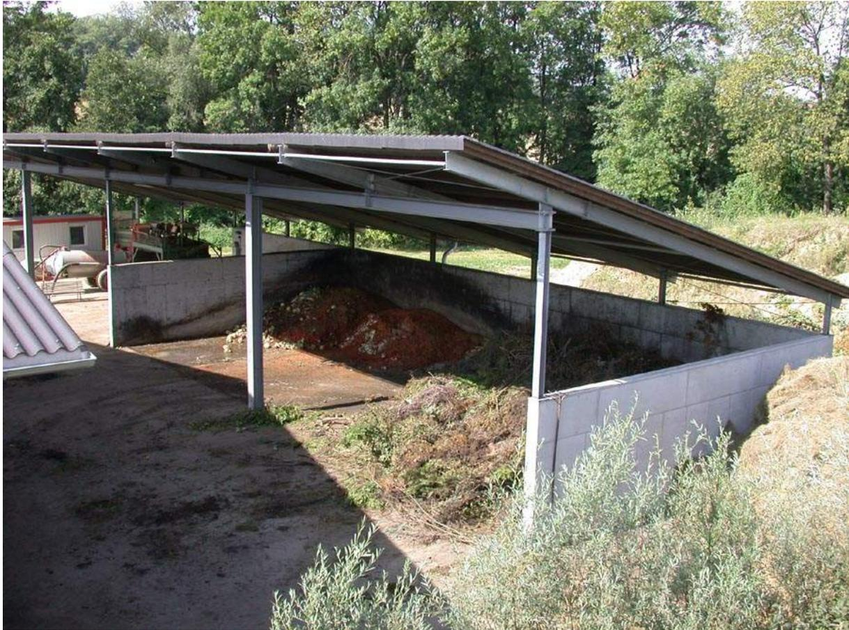
**Abbildung 9-2: Beispiel für einen Überdachten Annahmebereich mit getrennten Sektoren für Grüngut und Biotonne, bzw. nicht verholzte Gewerbeabfälle**
