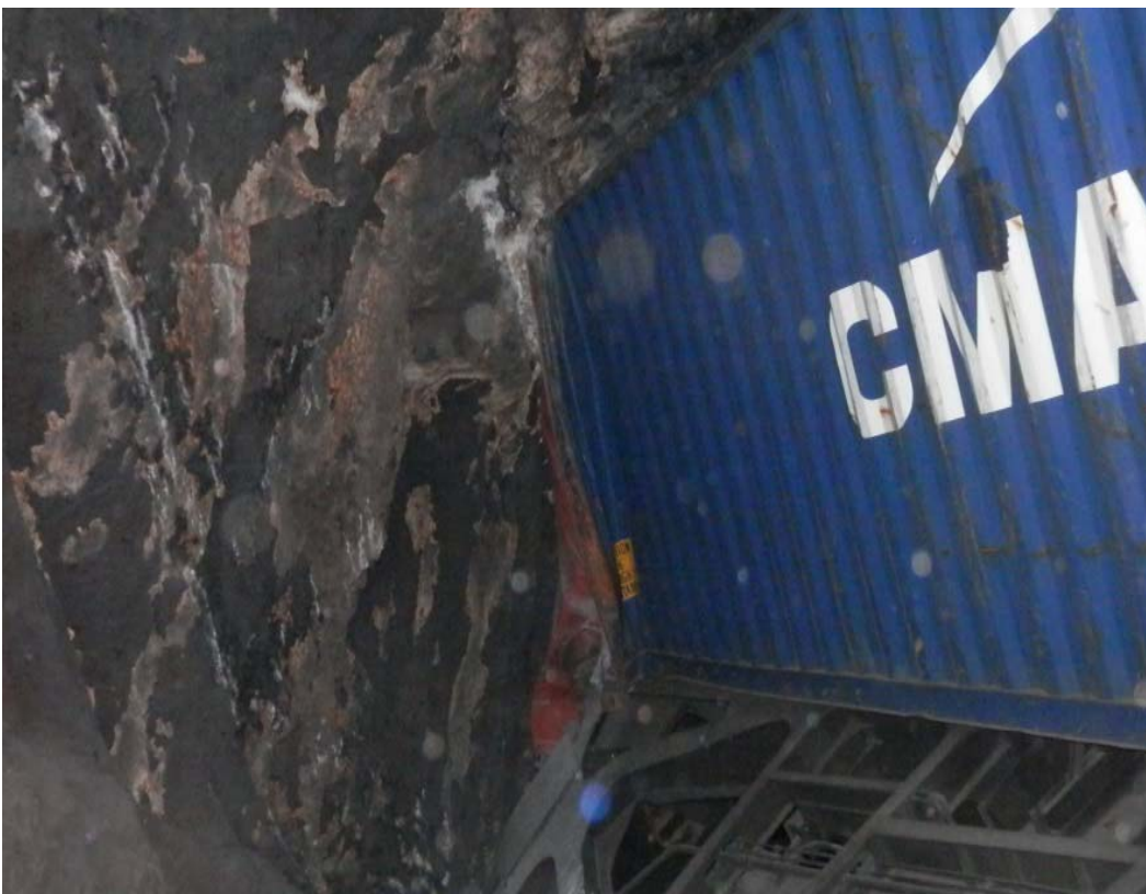
Abbildung 11: Z 43601 – Beschädigte Fahrzeuge im Tunnelbereich (Quelle SUB)
