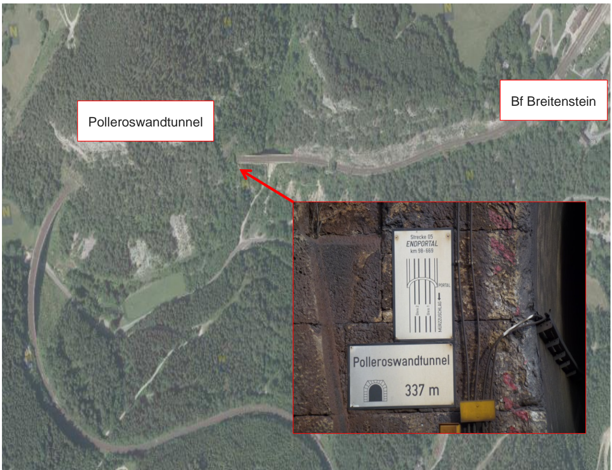
Abbildung 3: Luftbild Semmeringstrecke, Bereich Polleroswandtunnel (Quelle Google, IM)
