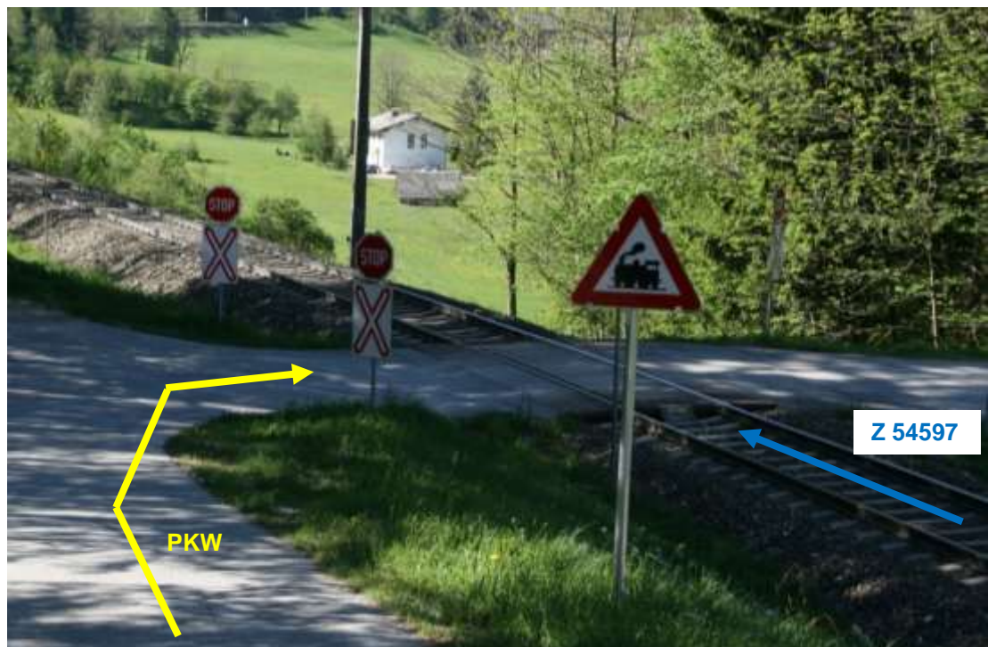
Abbildung 3 Ansicht der EK aus Fahrtrichtung des PKW
