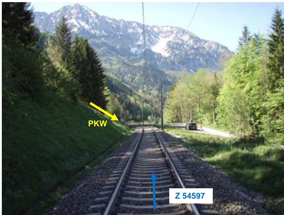
Abbildung 14 Ansicht der EK km 90,107 in Fahrtrichtung Z 54597
