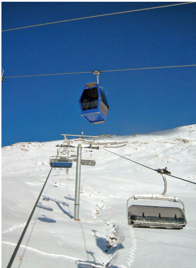
Beispiel einer Überkreuzung einer kuppelbaren Sesselbahn durch eine Kabinen-Umlaufbahn
