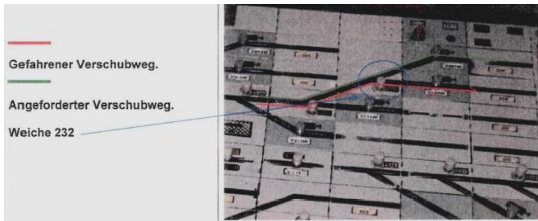
Abbildung 8 Sicherungsanlage Stw 2 (Quelle ÖBB-Infrastruktur AG)
