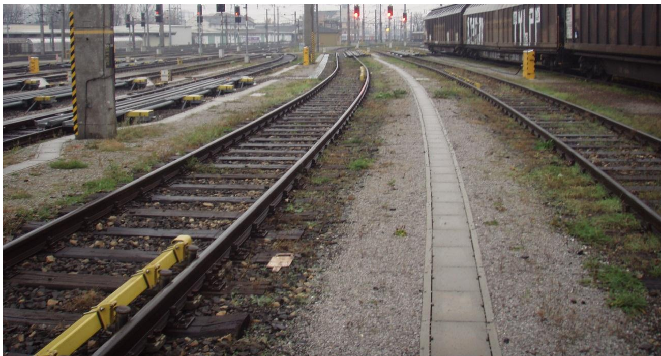
Abbildung 5 Gefälleausgleichsbremse – versenkbare Retarderbremsen im IM-Bf (Quelle SUB)
