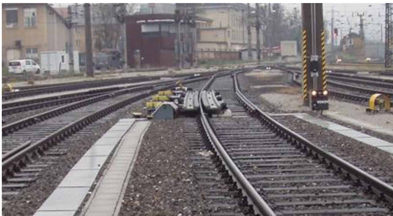
Abbildung 4 Richtungsgleisbremse im IM-Bf (Quelle SUB)
