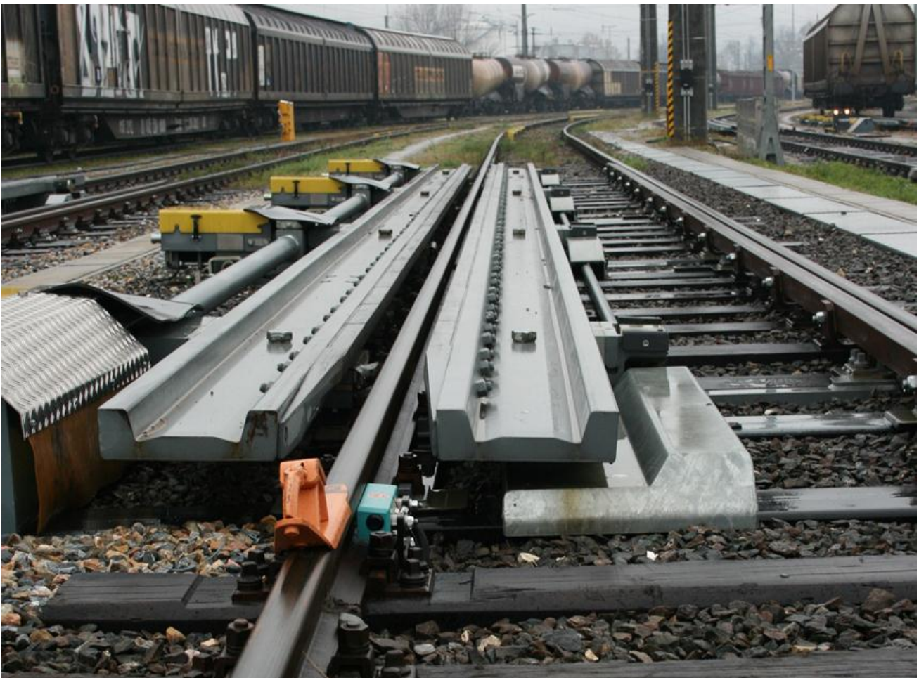
Abbildung 7 Entrollschutz durch ASiB (Quelle SUB)
