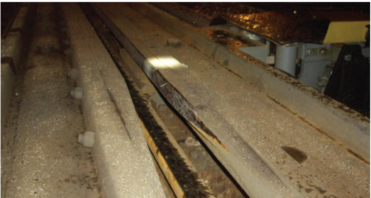
Abbildung 9 Entgleisungsspuren auf ASiB (Quelle IM)
