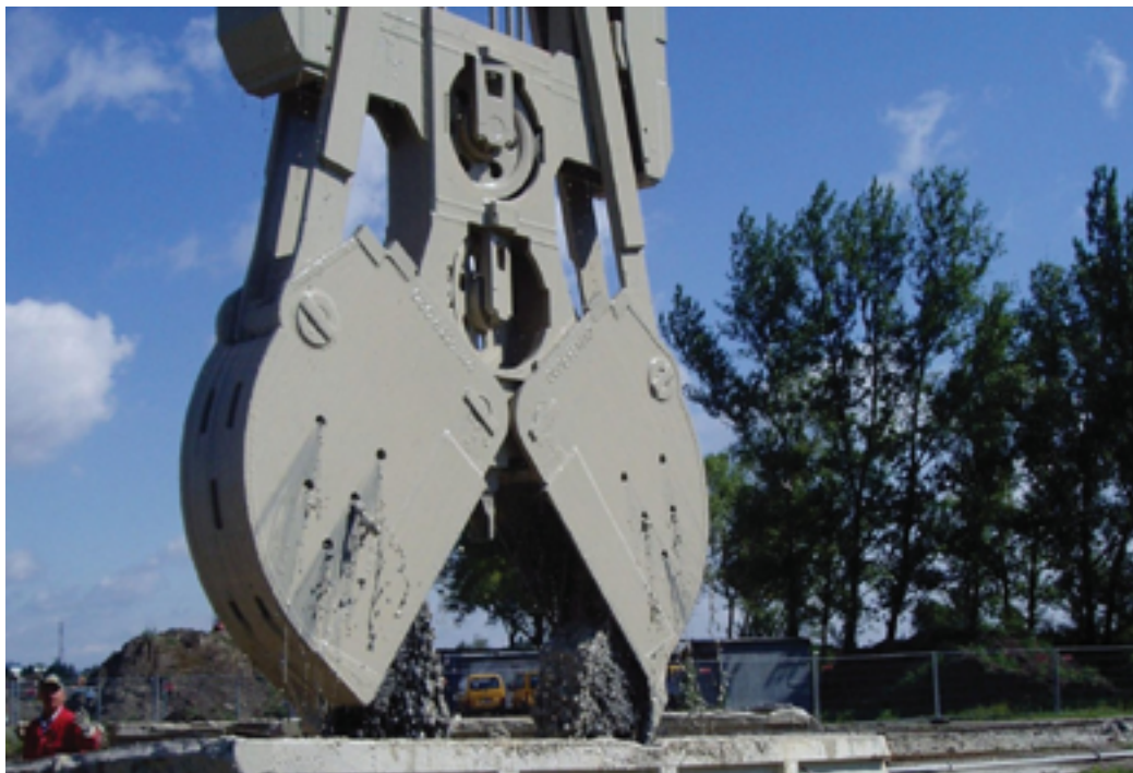
Abbildung 159: Schlitzwandaushub
