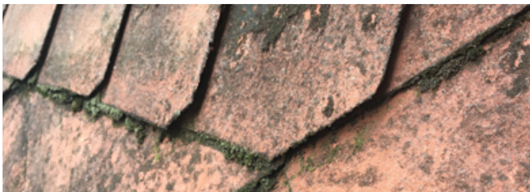
Abbildung 44: Asbesthaltige Dachplatten
