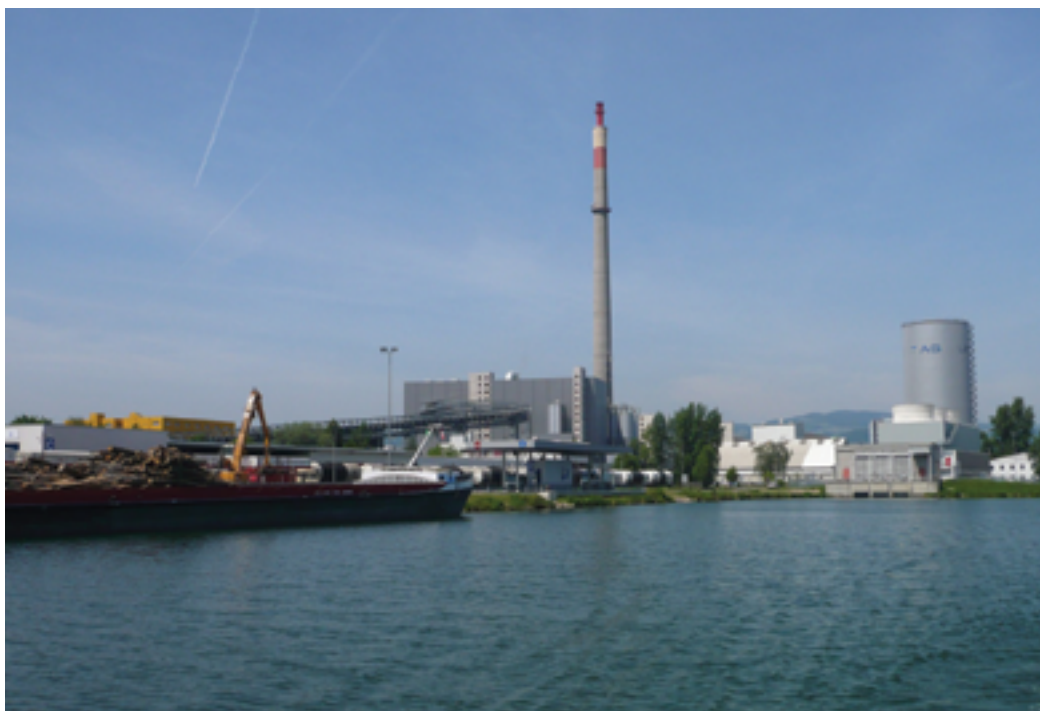
Abbildung 54: Thermische Behandlungsanlagen für Siedlungsabfälle
