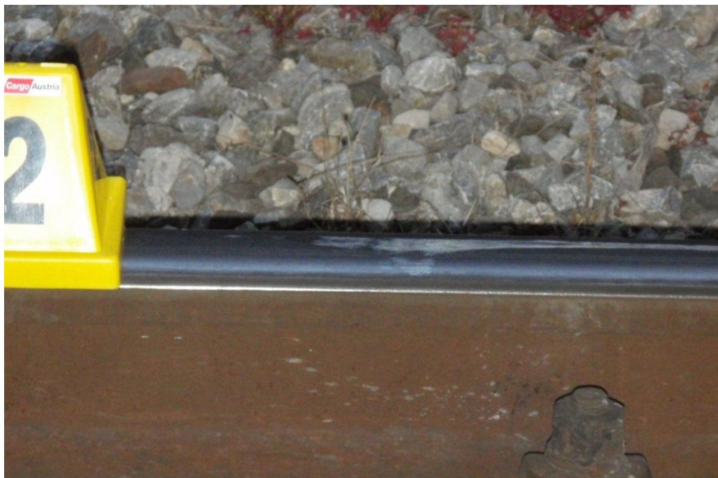
Abbildung 19 Spuren des gebremsten Rades am rechten Schienenstrang (2) - Quelle IM
