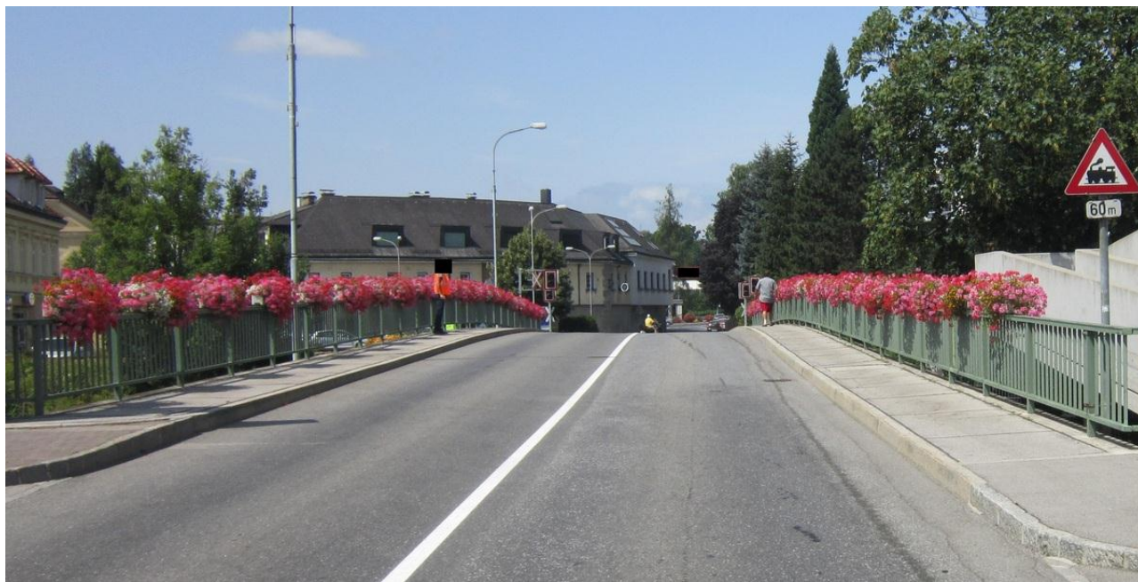
Abbildung 12 EK mit Gefahrenzeichen „Bahnübergang ohne Schranken“ rechts im Bild (Quelle SUB)
