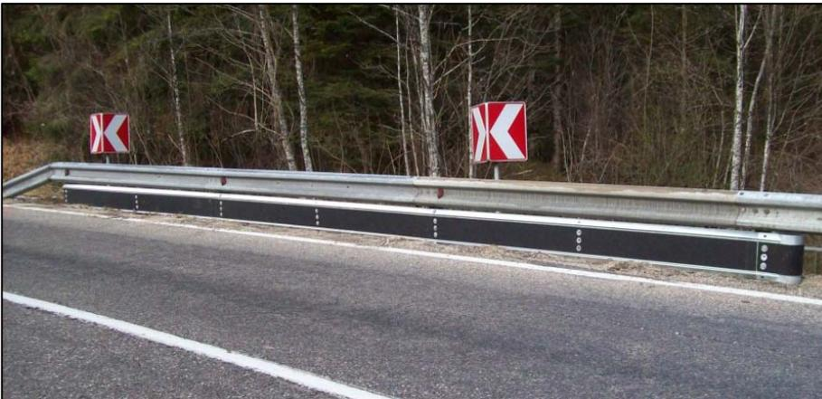
[Abbildung 6](#): Prototyp eines Unterfahrschutzes (Leitschienenunterzug)
