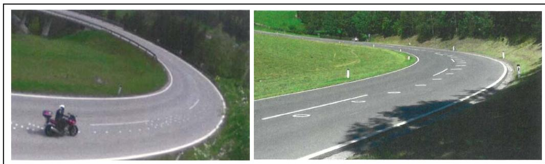
Abbildung 13: Formen der erprobten Bodenmarkierungen (Links: B95, km 55,200; Rechts: B105, km 4,400) [24]
