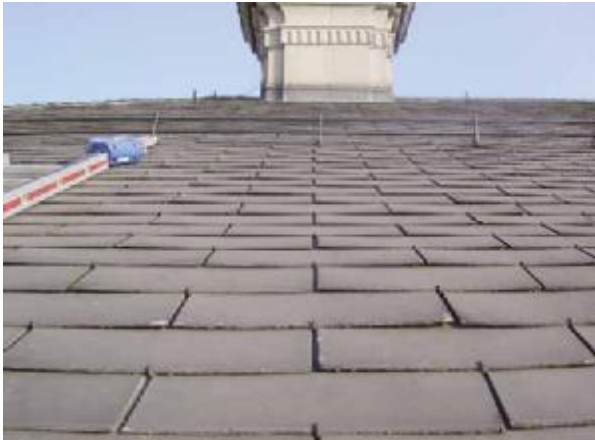
Foto 3: Dach mit Asbestzementschindeln (Eternit) gedeckt (SUVAPRO 2007)
