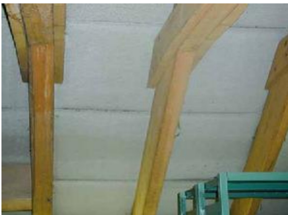
Foto 5: Dach mit Faserzementplatten innen isoliert (SUVAPRO 2007)
