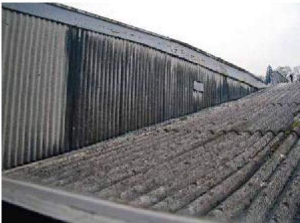
Foto 4: Welldach mit asbesthaltigen Faserzementplatten (SUVAPRO 2007)
