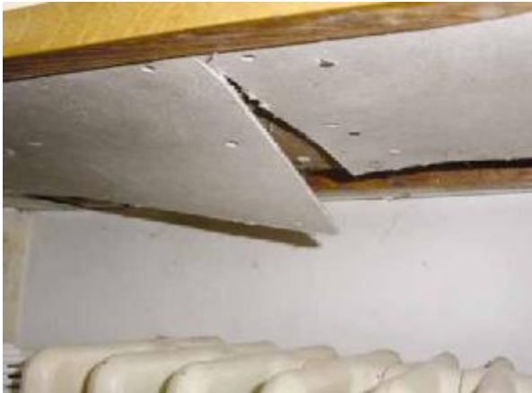
Foto 6: Asbestleichtpressplatten zur thermischen Isolation einer Fensterbank (SUVAPRO 2007)
