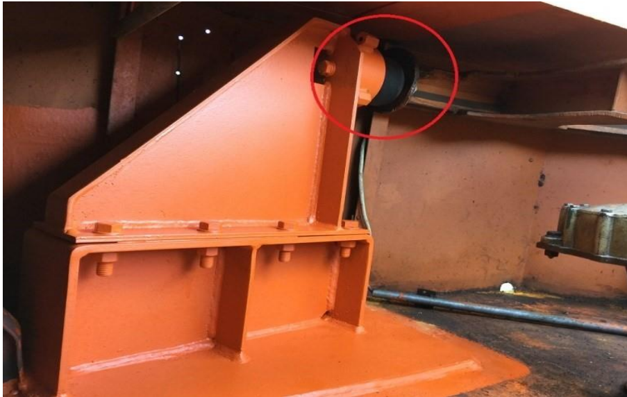
Abbildung 21 Neu aufgesetzter linker Endanschlag - fluchtend mit der Anschlagplatte des linken Quadranten
