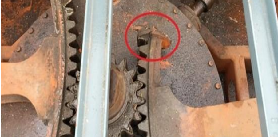
Abbildung 19 Eingerissene Anschlagplatte des rechten Quadranten der "SCHÖNBRUNN"
