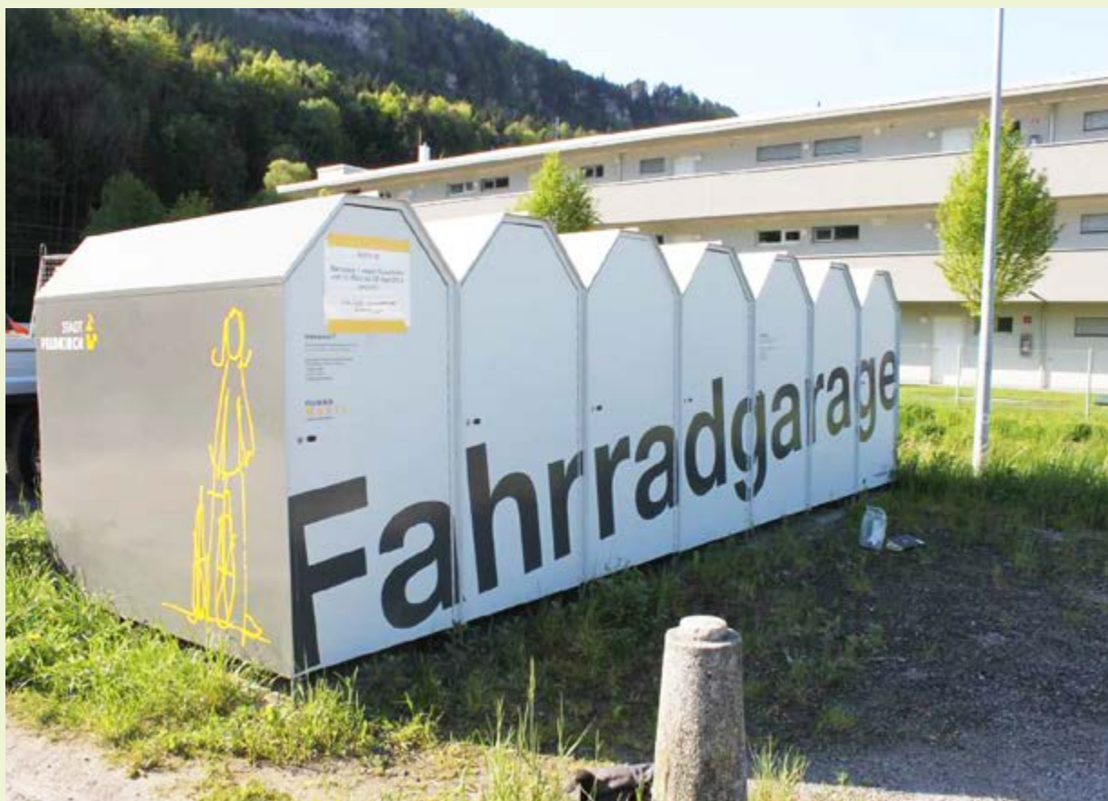
— Sanierte Fahrradboxen an der ÖBB-Bahnhaltstelle Feldkirch-Amberg
