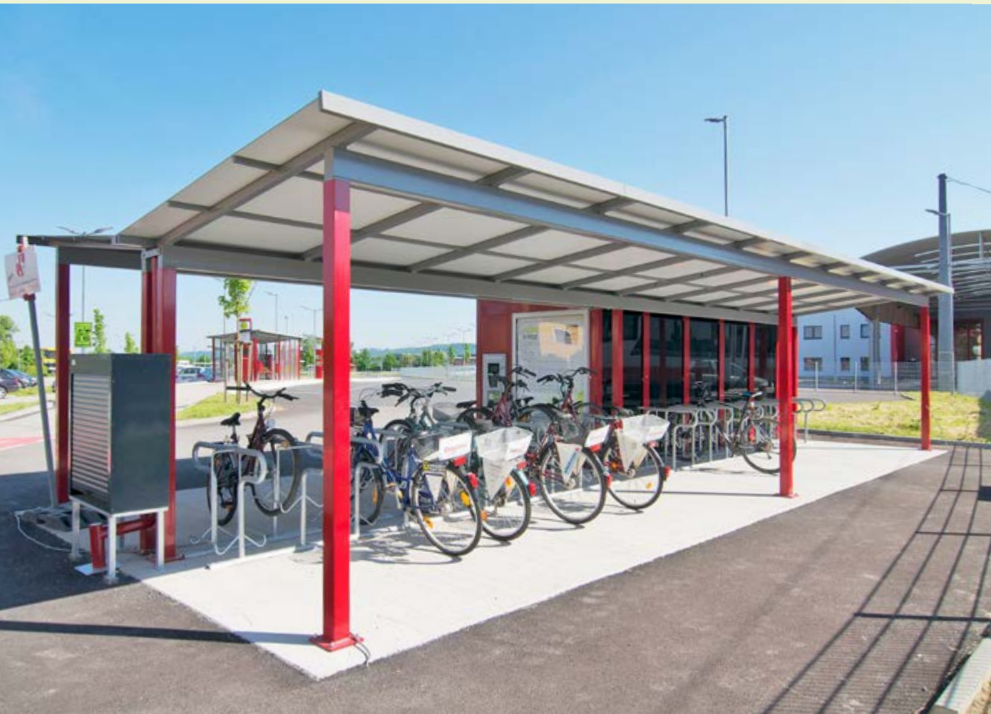
— Die überdachte B+R-Anlage bietet 38 Fahrradabstellplätze und 11 Fahrradboxen mit E-Ladestation
