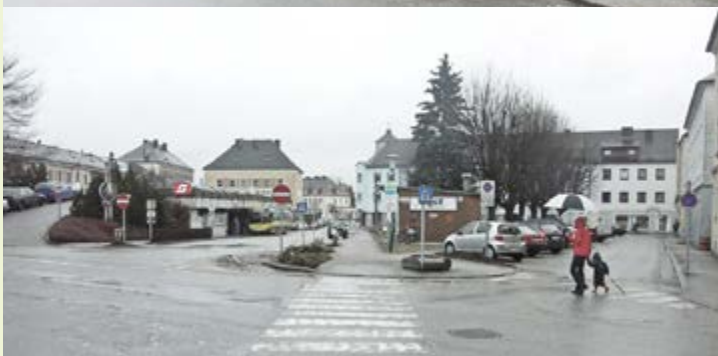
— Bahnhof und Bahnhofsvorplatz vor den Umbaumaßnahmen
