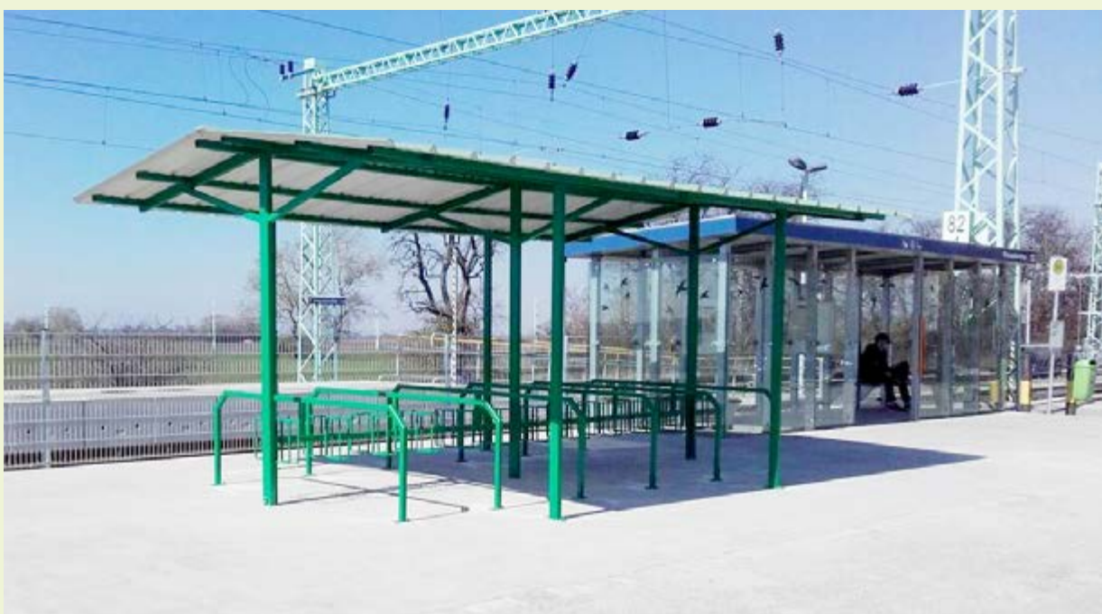
— Die Abstellanlage in Frauenkirchen
