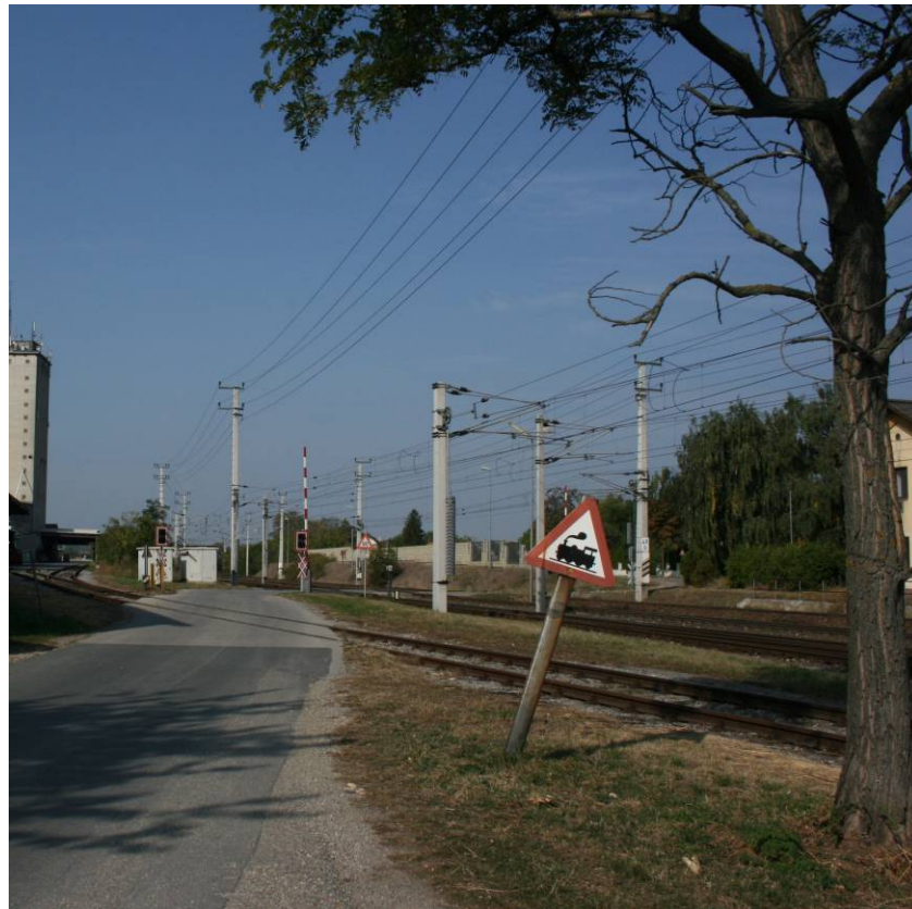
Abbildung 10 Beschädigtes Verkehrszeichen (Quelle: UUB)
