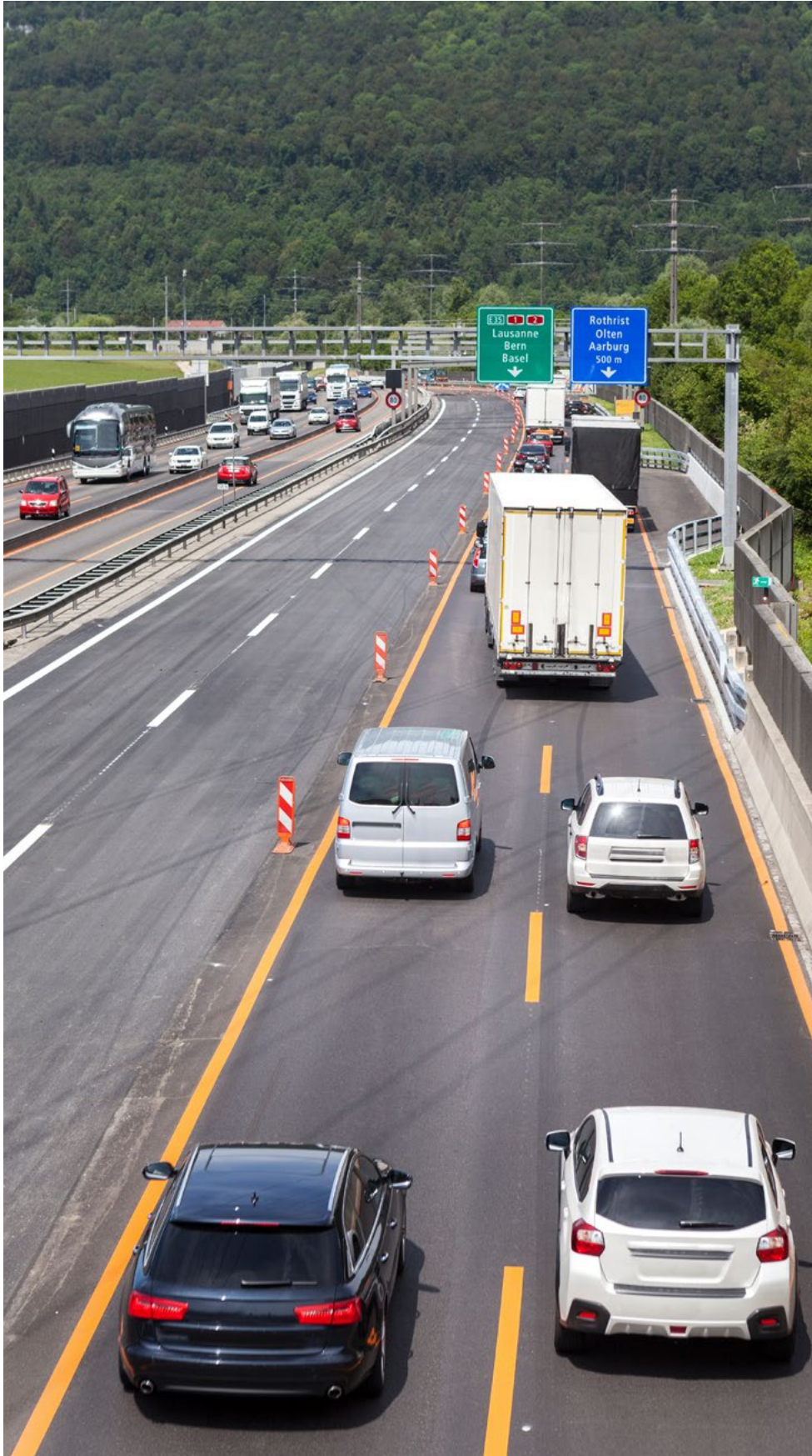
Autobahnbaustelle Schweiz, Quelle: stock.adobe.com
